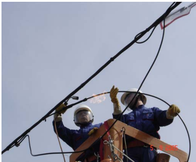
Slika 1 - Popravak SKS pod naponom
